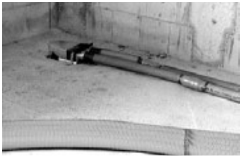
Fussbodenaufbau für die Verlegung des ValloFlex-RONDO, 63 mm
